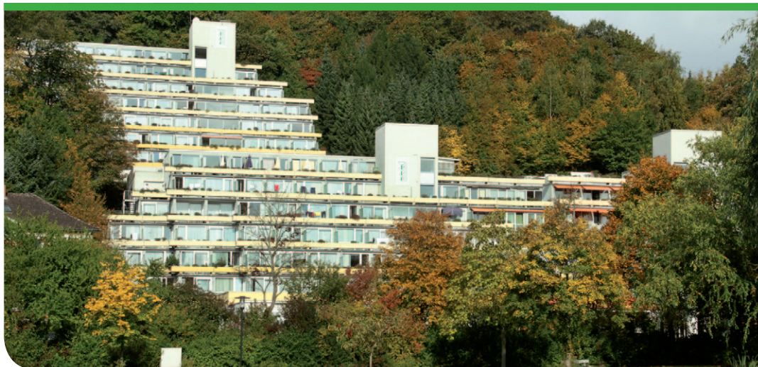
Das neue Paracelsus-Gesundheitszentrum ist in der ehemaligen Roswitha-Klinik untergebracht.
